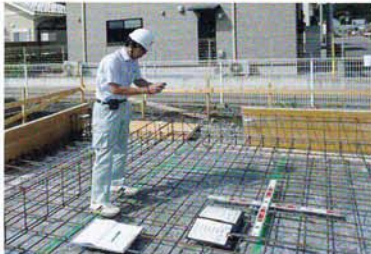
公的機関による鉄筋の検査を受けてます
