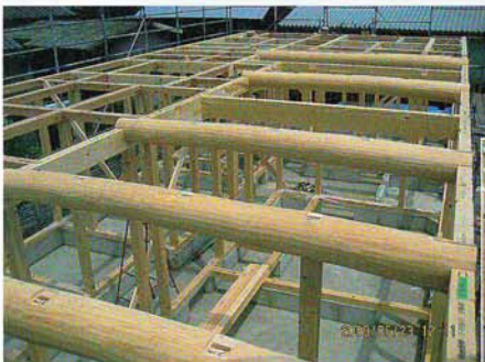
構造材は含水率18%以下を使用
