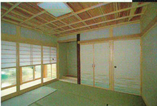
差し鴨居工法の和室、床柱は朱丹、本京壁、本格的な杉柵縁天井と雪見障子。
