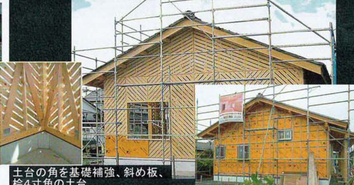
構造材は含水率18%以下を使用
