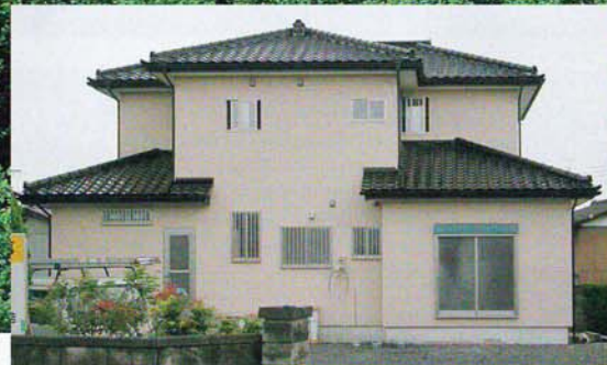
外装は厚み37ミリの不燃材の上に吹付け塗装
