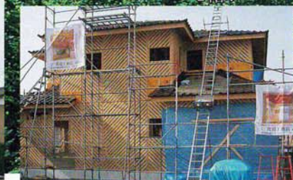
建物全面に幅90ミリ厚さ15ミリの桧の板を釘で斜めに一枚一枚しっかりと打ち付けます
