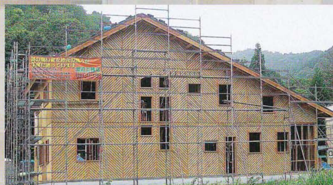
(耐震壁面の外観)
