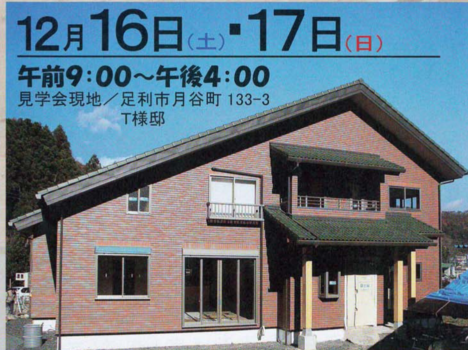
高級感漂う本物総タイル貼りの外装、太い桧の柱の玄関▲
